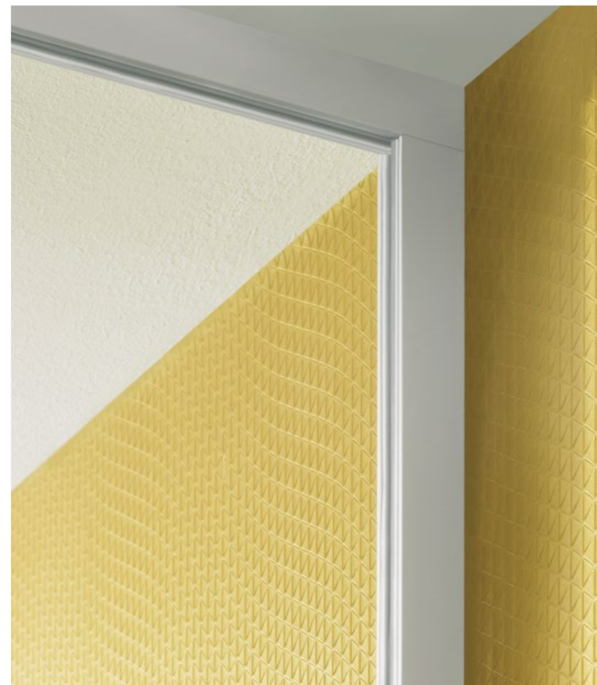
4 Systèmes de profilé MR 22 / MR 28 Les profilés périphériques représentent une connexion fine au bâtiment, tandis que les profilés de croisillon peuvent être utilisés comme raccordement entre les surfaces vitrées.
